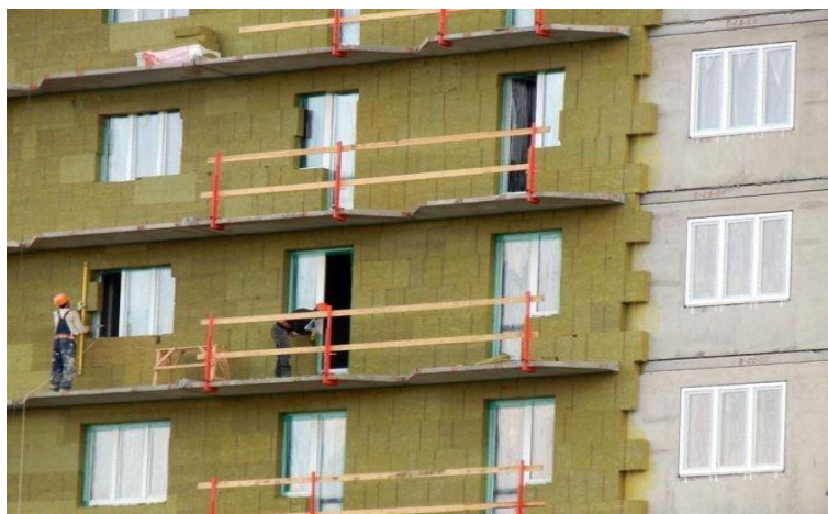
1-rasm. Bazalt materiallarini ko‘p qavatli uylar devorlariga o‘rnatilish jarayoni.
